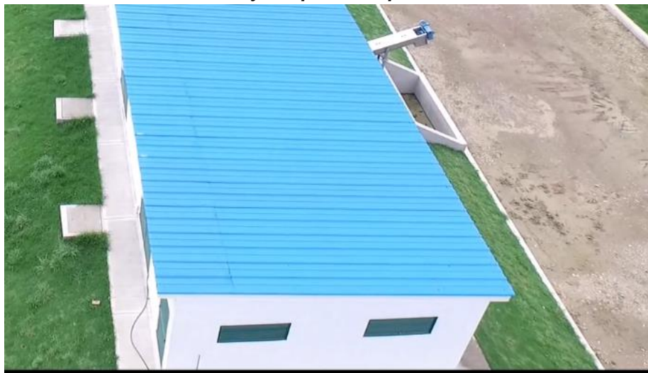
Figura 17. Caseta de filtro Banda y tanque de disposición de lodos
