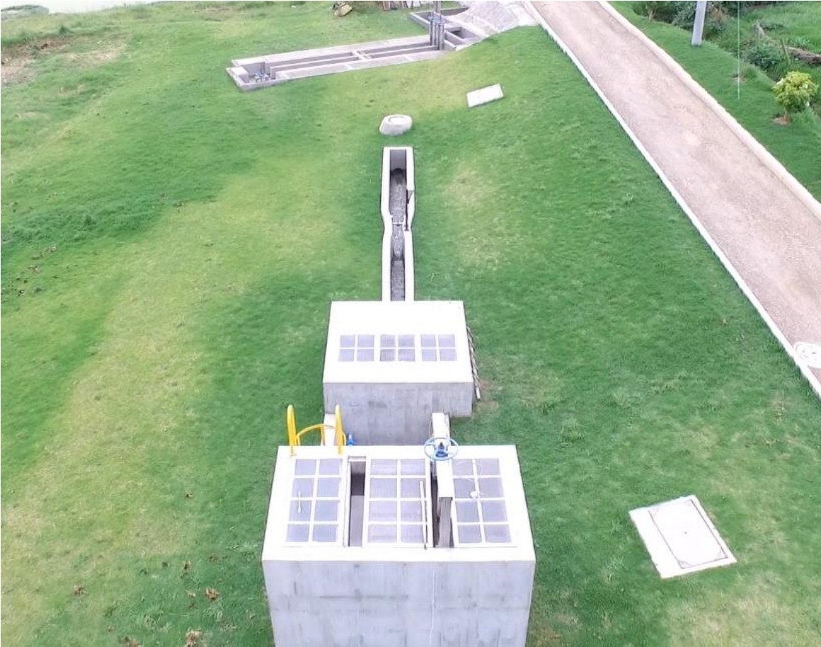
Figura 13. Canal aforador, estación de bombeo y tanque de compensación
