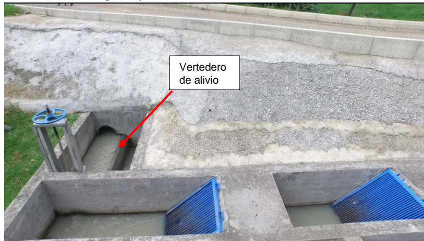
Figura 11. Cámara de llegada y sistema de cribado
