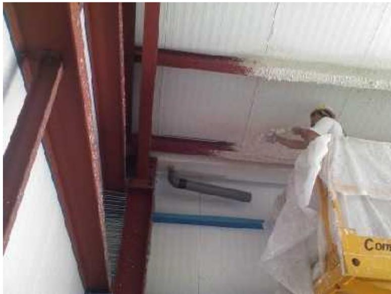
**Ilustración 6.1: Aplicación sobre una estructura de la pintura intumescente**
