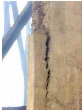
**Figura 4.11: Descascaramiento en una columna de concreto expuesta al fuego.**
