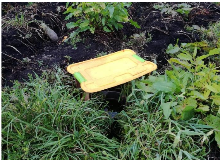
Fotografía 2. Punto de muestreo No. 01: Tanque de captación agua de escorrentía
