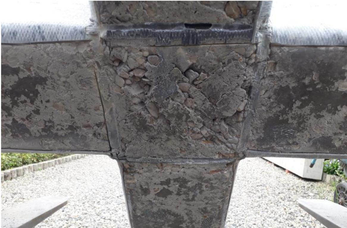
**Figura 5-11:** Falla localizada en la base de la columna
