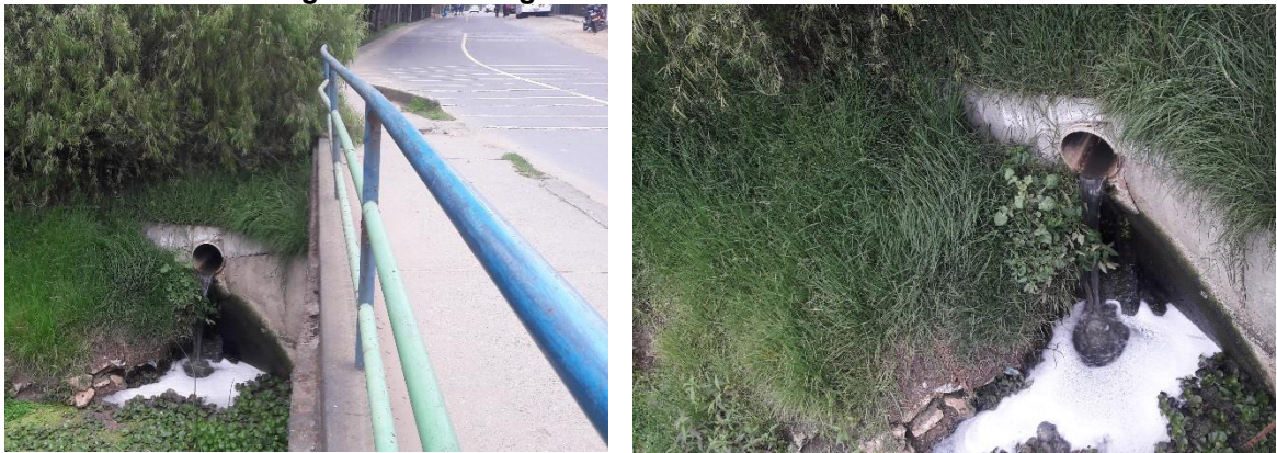
Fotografía 4. Descarga sobre canal Torca – Sector Cafam
