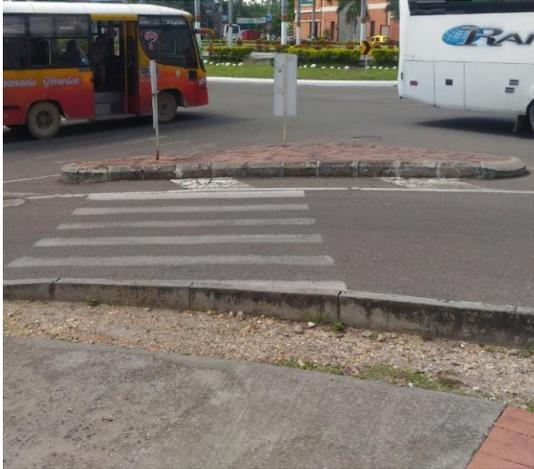
Fotografía 33 Sin demarcación para el paso peatonal e isla de descanso totalmente insegura
