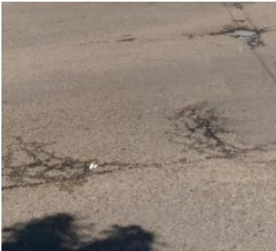
Fotografía 17 Fisuras en el pavimento, longitudinales y transversales
