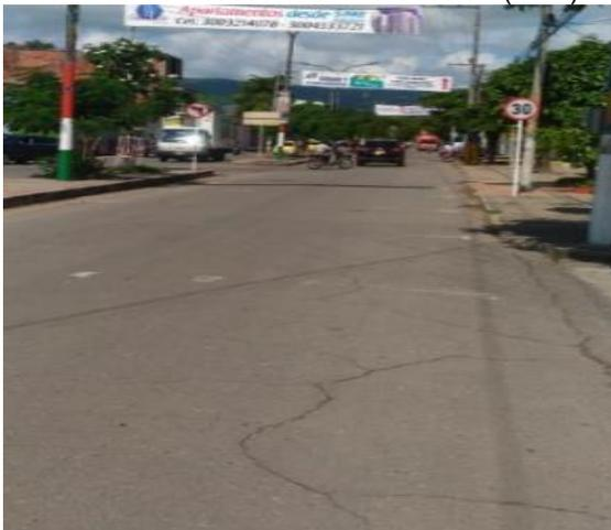
Fotografía 6 Ausencia de demarcación de la calzada de acceso (W-E)
