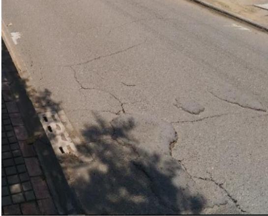
Fotografía 15 Desgaste de la capa de rodadura, síntomas de fatiga del pavimento
