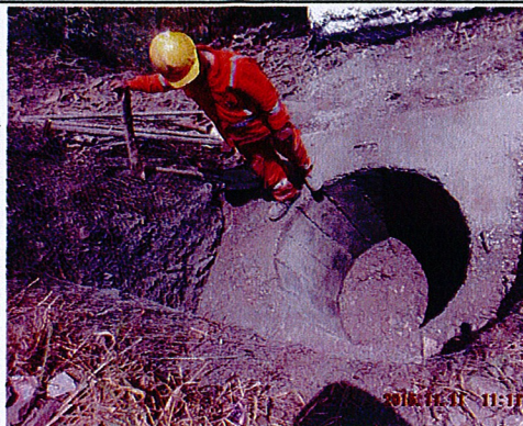
Fotografía No. 38 Primer anillo de excavación fundido.
