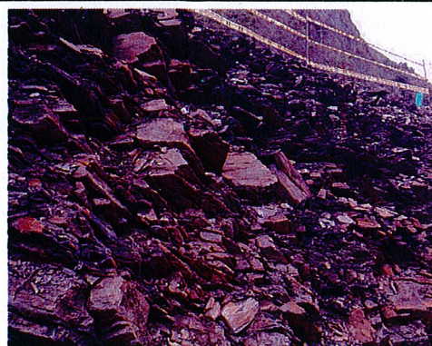
Fotografía No. 42 Talud zona de estudio.
