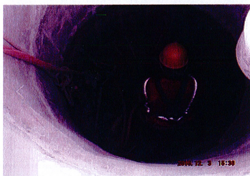
Fotografía No. 15 Excavación in-situ.
