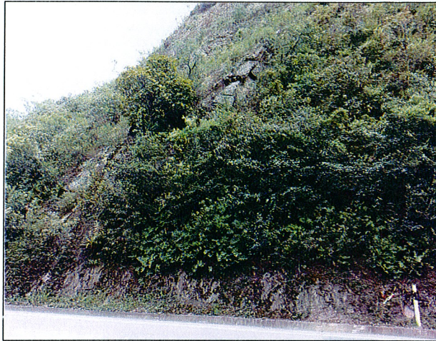
Figura 4-20 Talud de la vía actual frente a K38+808
