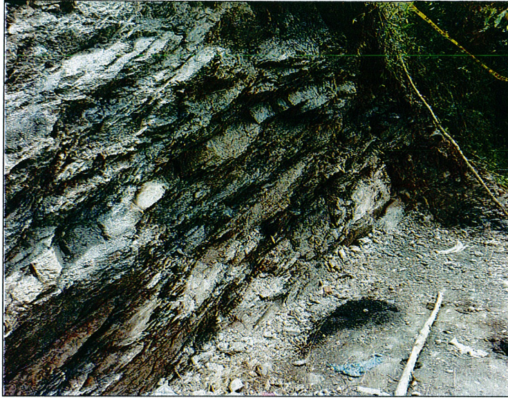
Figura 4-18 Talud del banqueo frente K38+604
