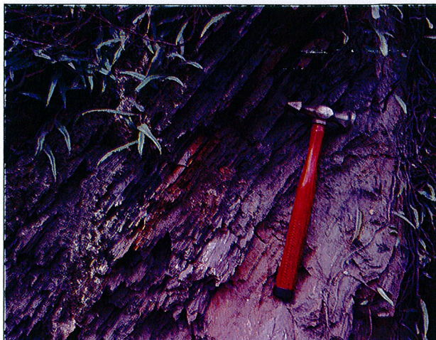
Figura 3-19 Aspecto en detalle de la roca en el talud del K38+800.
