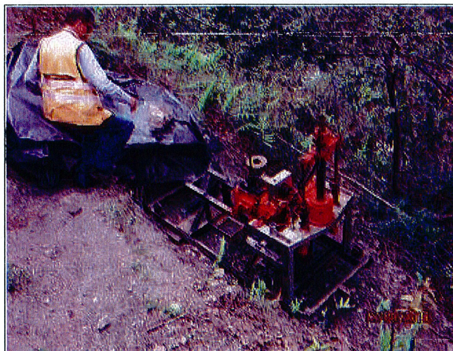
Figura 4-1 Inspección de campo a los trabajos de perforación.
