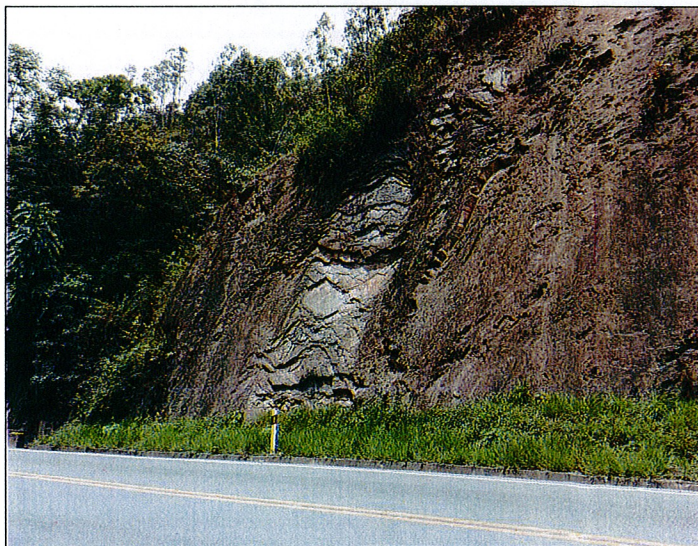
Figura 4-19 Talud de la vía actual frente K38+740
