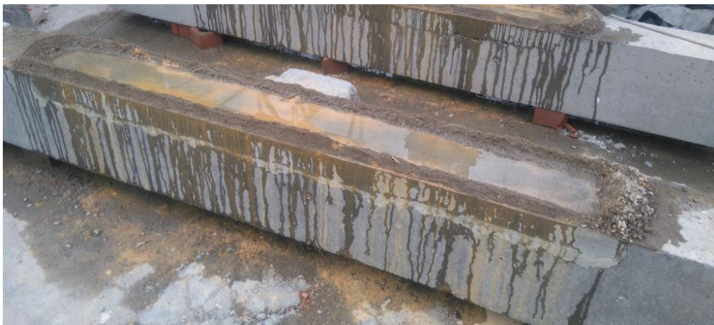
Fotografía 4.35 Proceso de Curado de la viga V2
