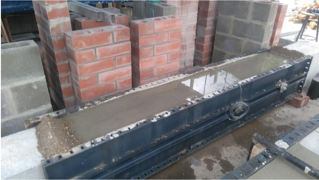
Fotografía 4.36 Proceso de Curado de la viga V3
