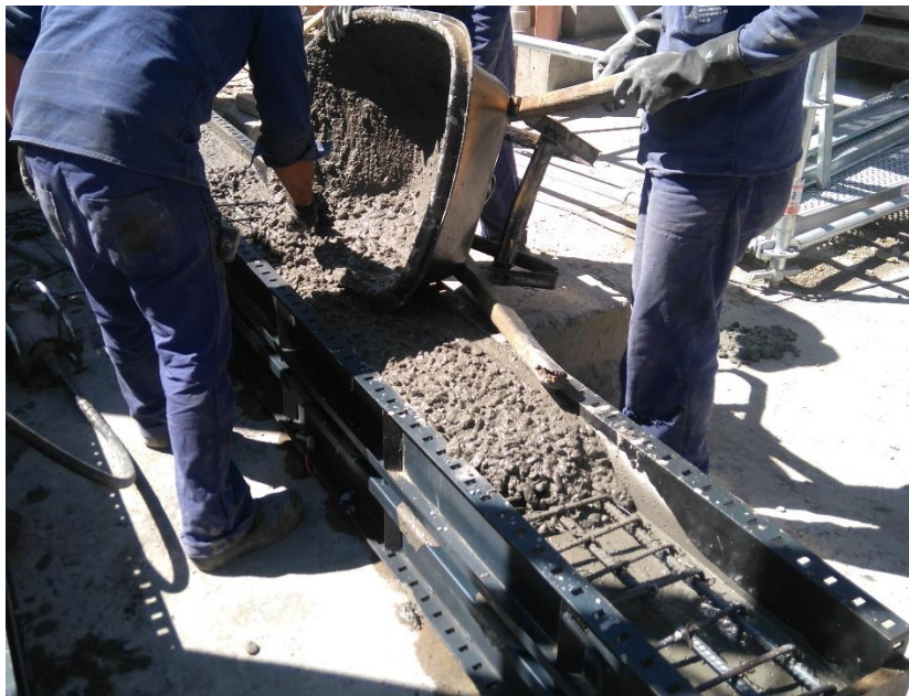
Fotografía 4.1 Proceso de construcción de la viga V1A
