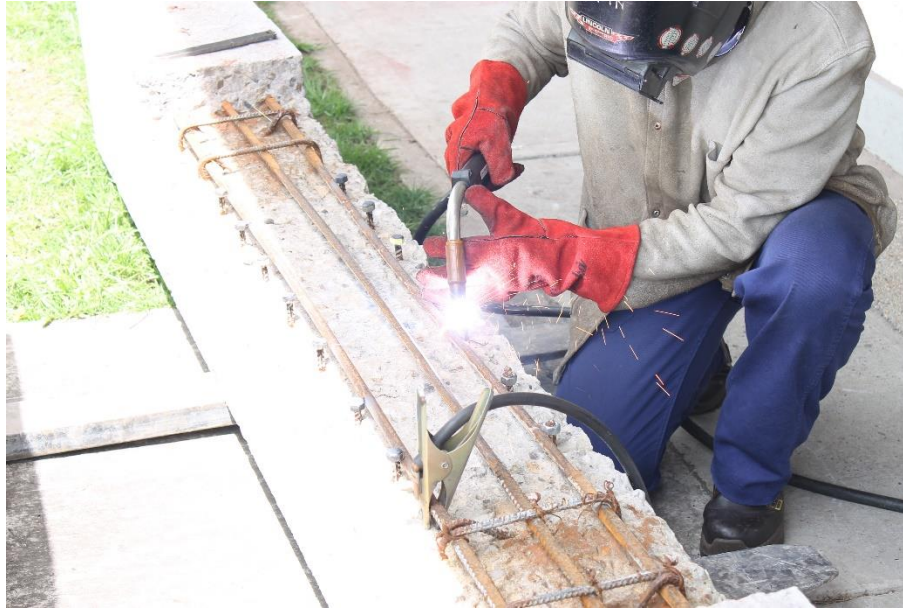
Fotografía 4.23 Proceso de instalación de las tuercas soldadas a los estribos existentes
