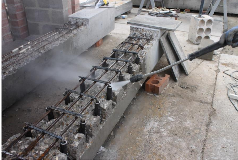
Fotografía 4.30 Hidrolavado de la sección a reparar en la viga V4
