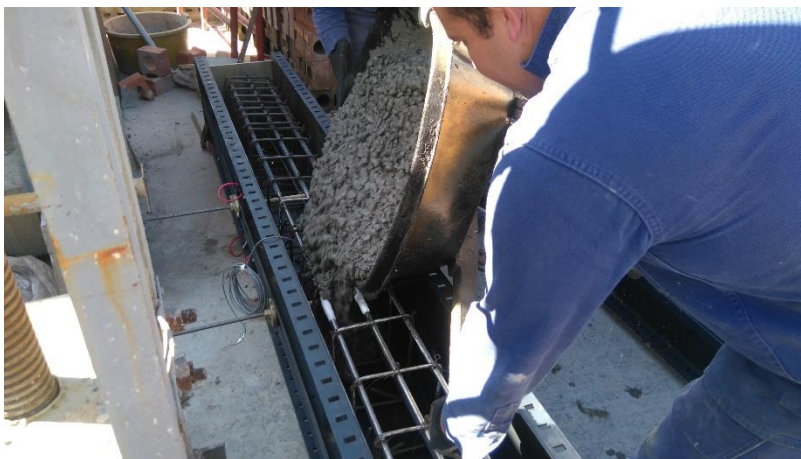
Fotografía 4.3 Proceso de construcción en la viga V1B
