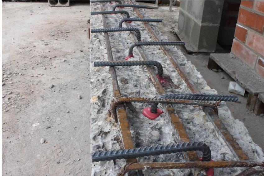
Fotografía 4.19 Anclajes epóxicos en la viga V5
