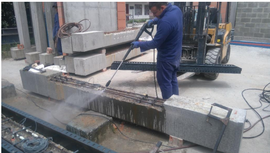
Fotografía 4.29 Hidrolavado de la sección afectada por corrosión en la viga V2
