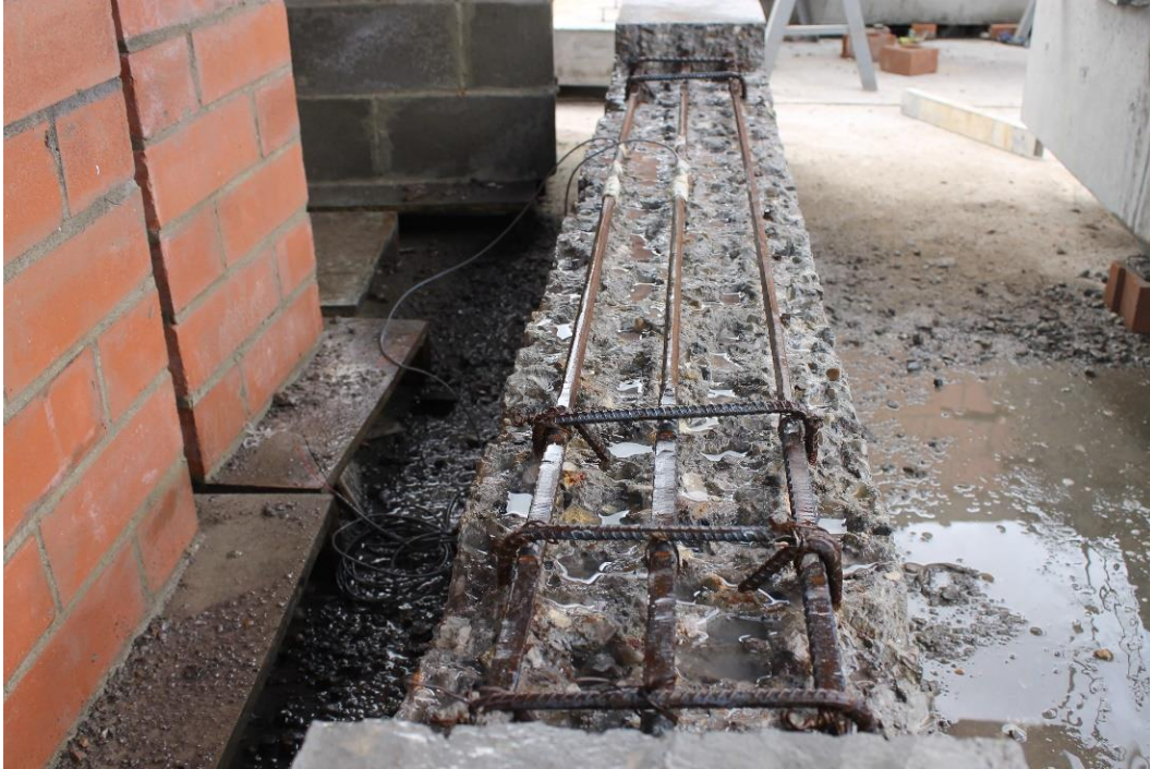
Fotografía 4.28 Encharcamiento de la zona a reparar después del hidrolavado en la viga V3
