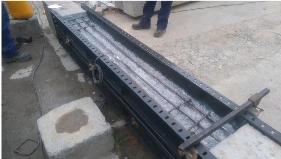
Fotografía 4.14 Aplicación del puente de adherencia Sikadur 32 – Primer en la viga V2
