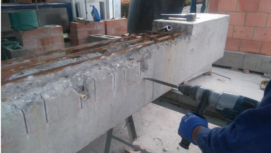
Fotografía 4.15 Demoliciones localizadas para la instalación de los acopladores en la viga V4
