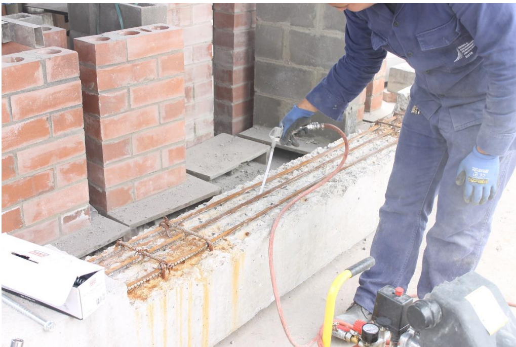
Fotografía 4.18 Sopleteado de las perforaciones en la viga V5
