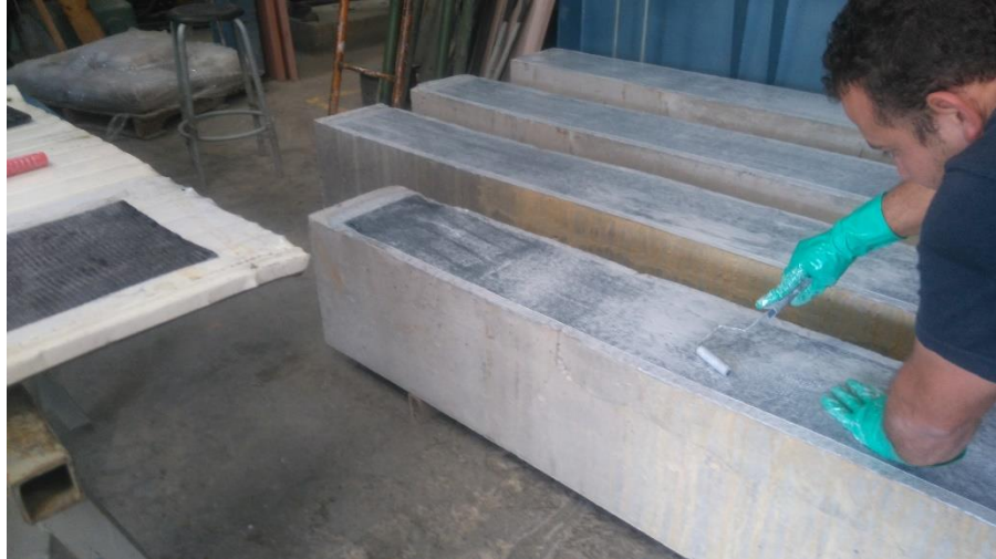
Fotografía 4.39 Extracción de las burbujas de aire en la pega de la fibra de carbono
