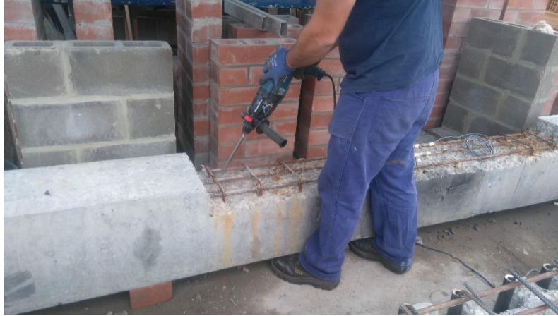
Fotografía 4.12 Remoción del concreto localizado sobre las barras longitudinales en la viga V6
