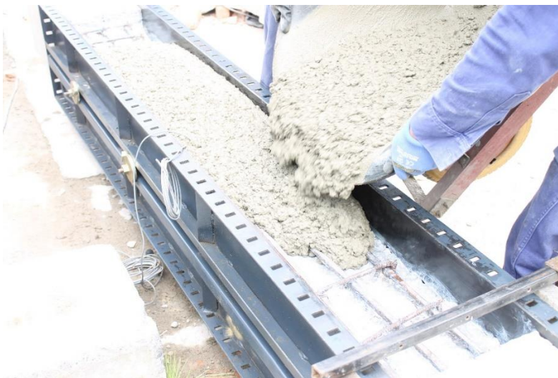
Fotografía 4.31 Vaciado del concreto de relación en la viga V2
