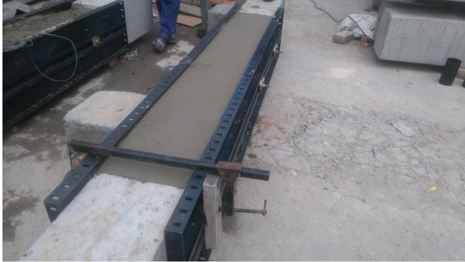
Fotografía 4.32 Estado final de la reconstrucción de la viga V2
