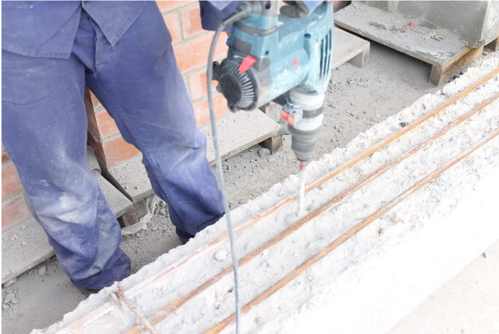
Fotografía 4.17 Perforaciones para los anclajes epóxicos en la viga V5
