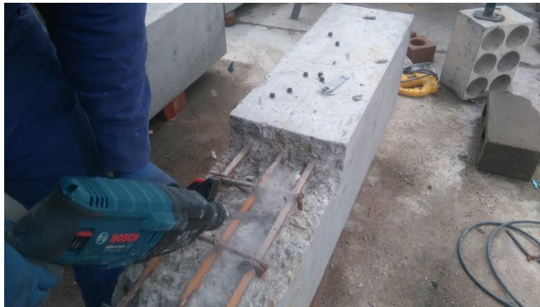
Fotografía 4.10 Remoción del concreto localizado sobre las barras longitudinales en la viga V2
