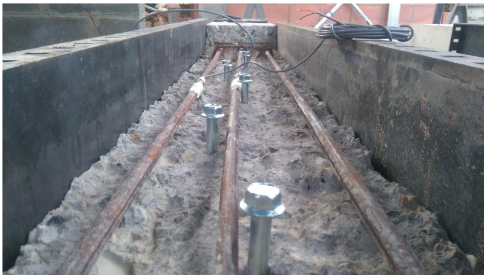
Fotografía 4.22 Sistema completo de transferencia de esfuerzos en la viga V6
