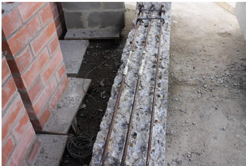
Fotografía 4.13 Remoción del concreto localizado sobre las barras longitudinales en la viga V7
