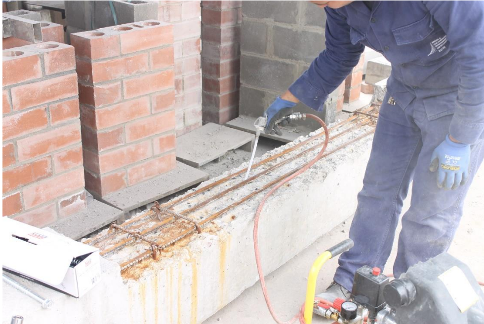
Fotografía 4.21 Sopleteado de las perforaciones en la viga V6
