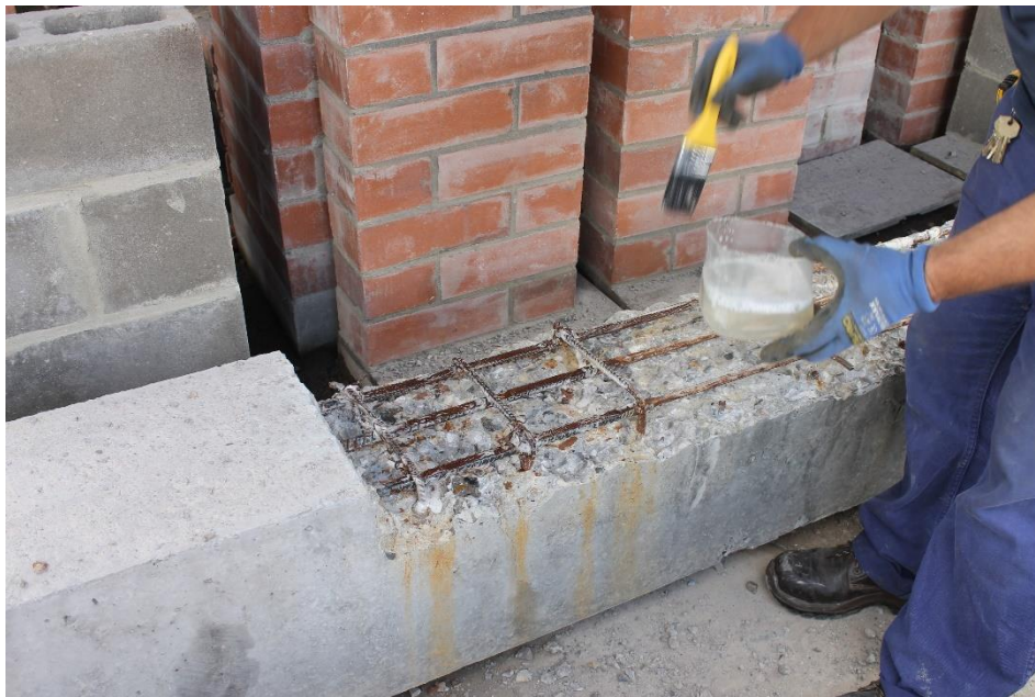
Fotografía 4.26 Limpieza química en las barras afectadas por corrosión en la viga V3
