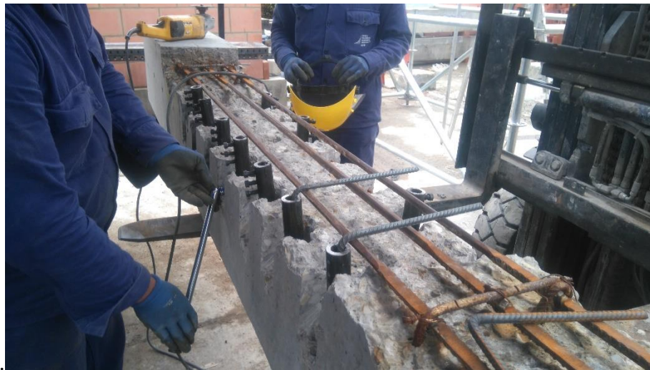
Fotografía 4.16 Instalación de los acopladores con llaves de torque en la viga V4
