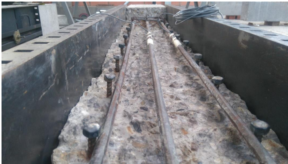
Fotografía 4.24 Sistema completo de transferencia de esfuerzos en la viga V7
