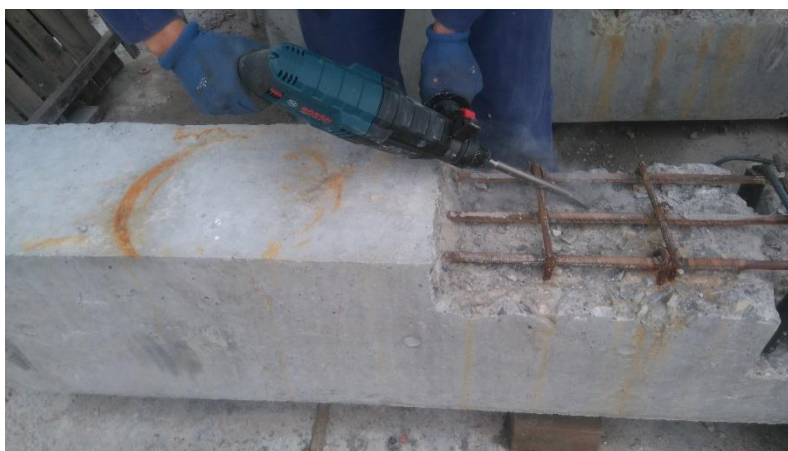
Fotografía 4.11 Remoción del concreto localizado sobre las barras longitudinales en la viga V4
