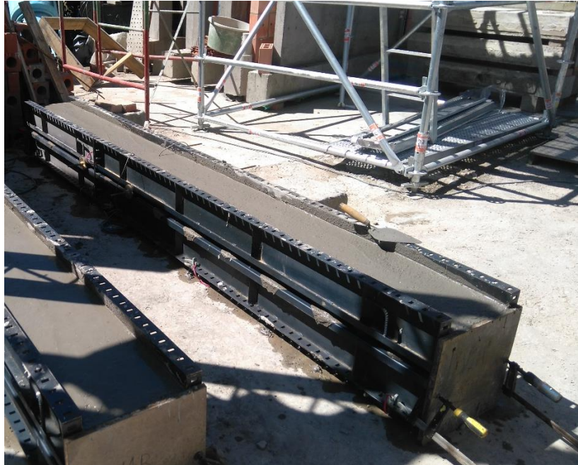
Fotografía 4.2 Proceso de construcción de la viga VIA
