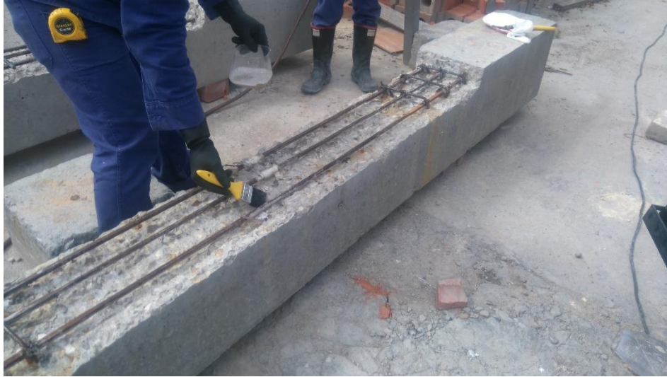
Fotografía 4.25 Limpieza química del acero afectado por corrosión en la viga V2
