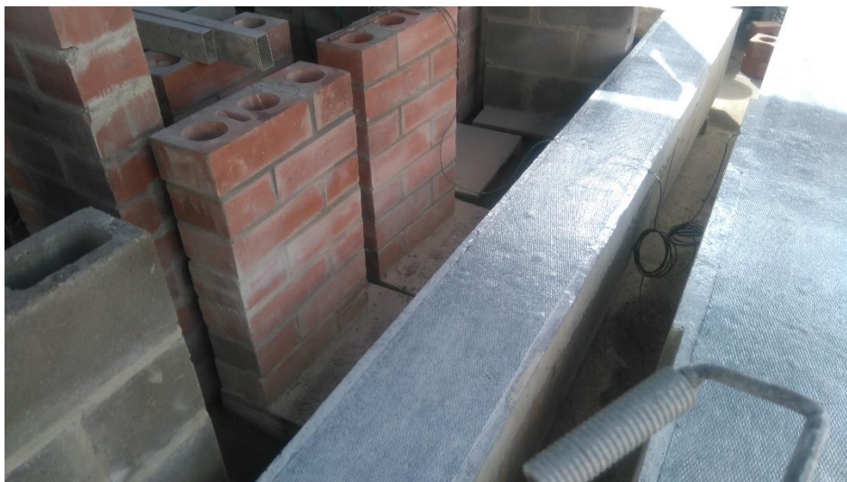
Fotografía 4.40 Estado final de la reparación de la viga V3 y V4
