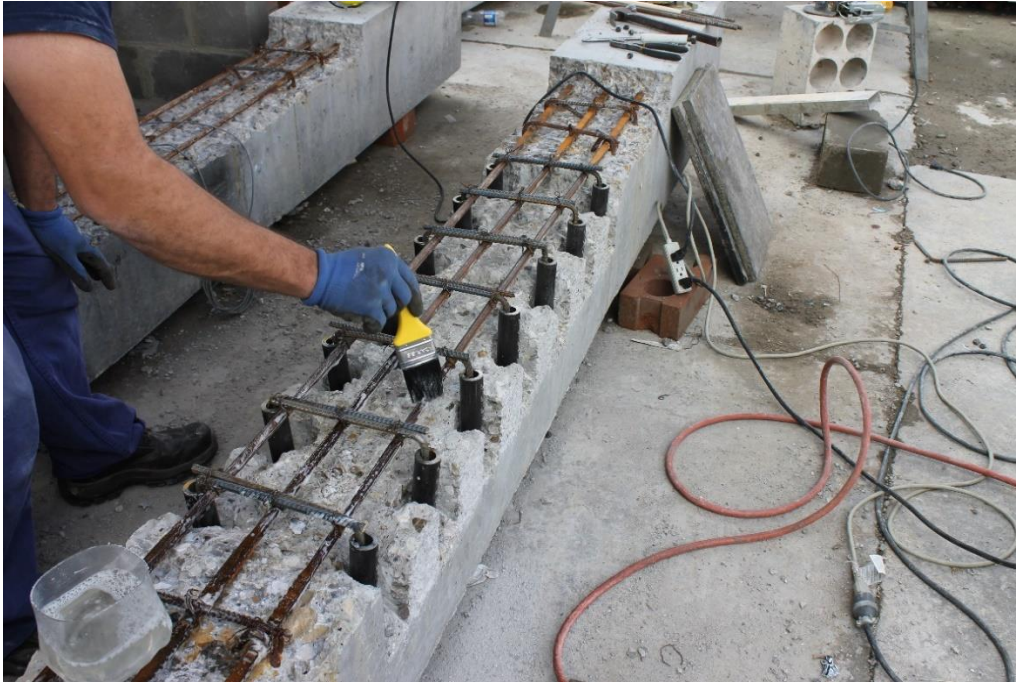
Fotografía 4.27 Limpieza química del acero afectado por corrosión en la viga V4
