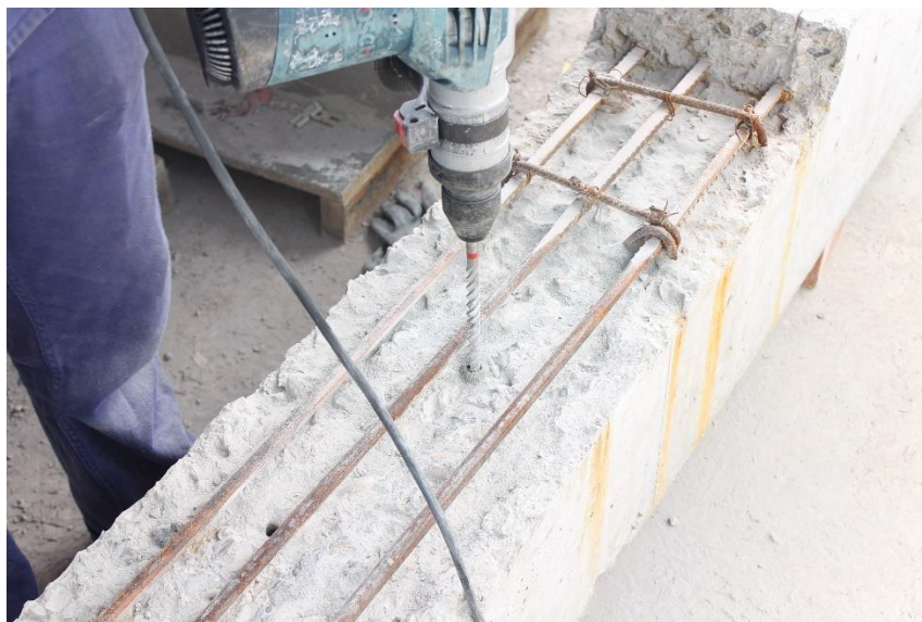
Fotografía 4.20 Perforaciones para anclajes atornillados en la viga V6
