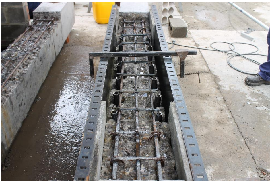
Fotografía 4.33 Recremento de la sección en la viga V4.
