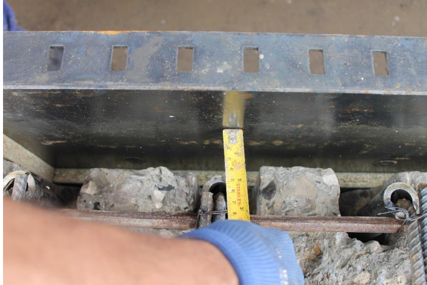
Fotografía 4.34 Verificación del recubrimiento de la zona reparada de la viga V4
