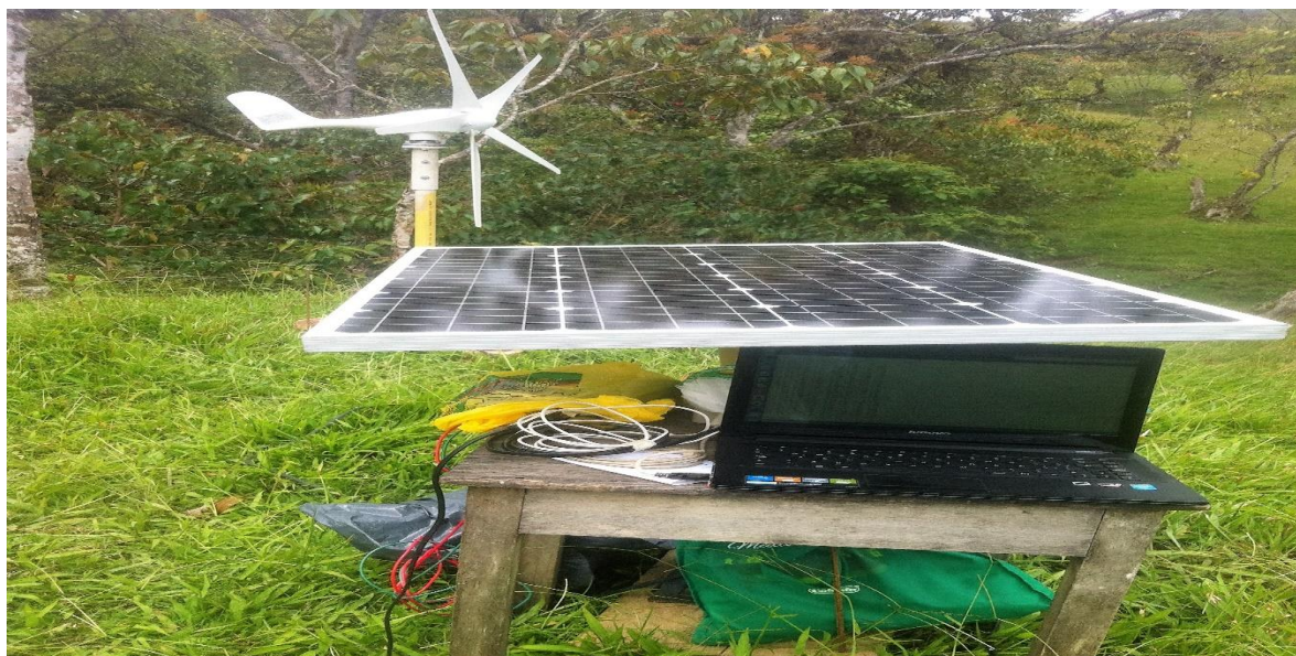
Figura 48 Foto prueba inicial de medición híbrida solar eólica vereda Josef municipio de Suaita Santander.
