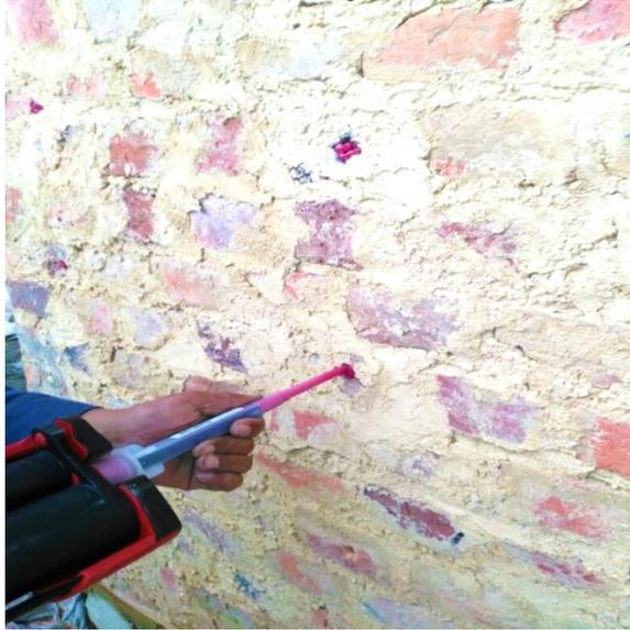
**Fotografía 4-33** Inyección de epóxico en los anclajes del refuerzo
