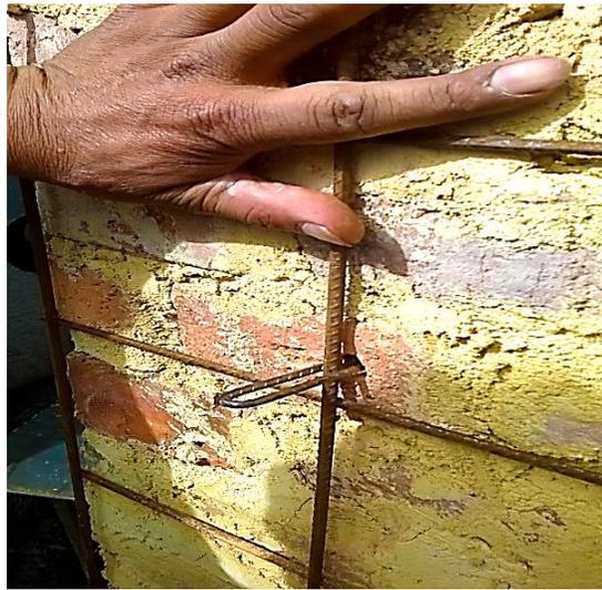
**Fotografía 4-31** Grafiles utilizados para el anclaje de la malla electrosoldada
