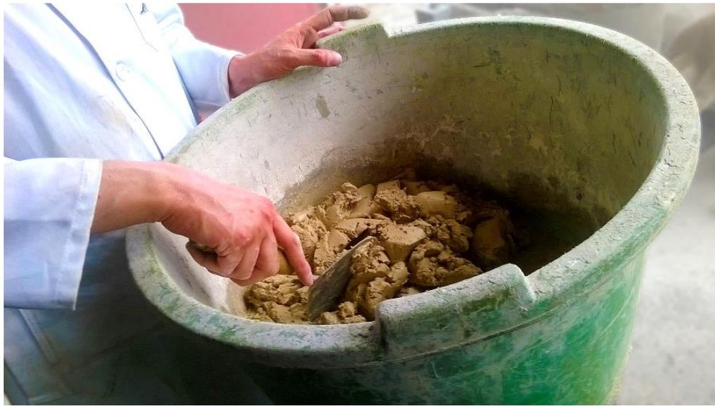
**Fotografía 4-12** Mezcla manual del mortero
