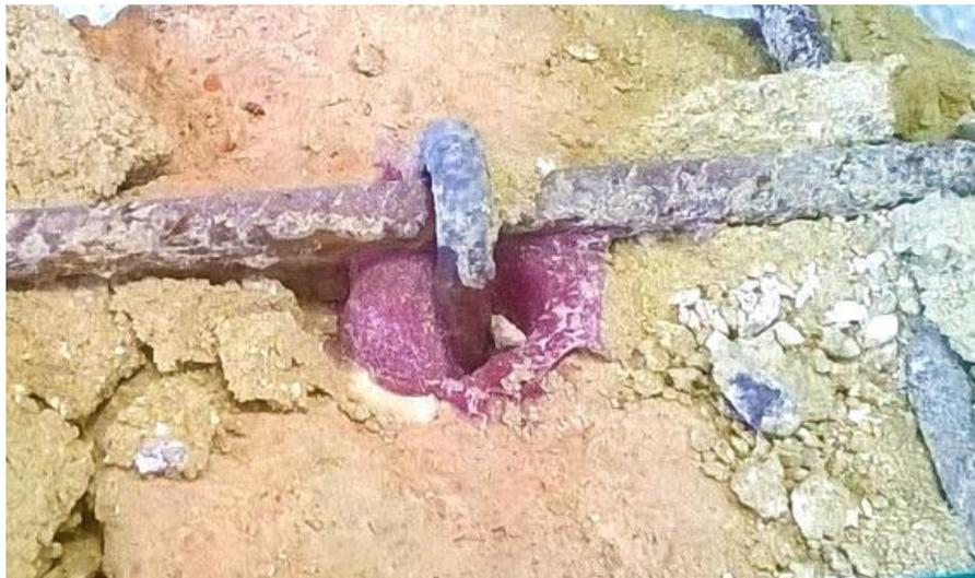
**Fotografía 5-15** Anclaje de la malla electrosoldada en murete de unidad y media
