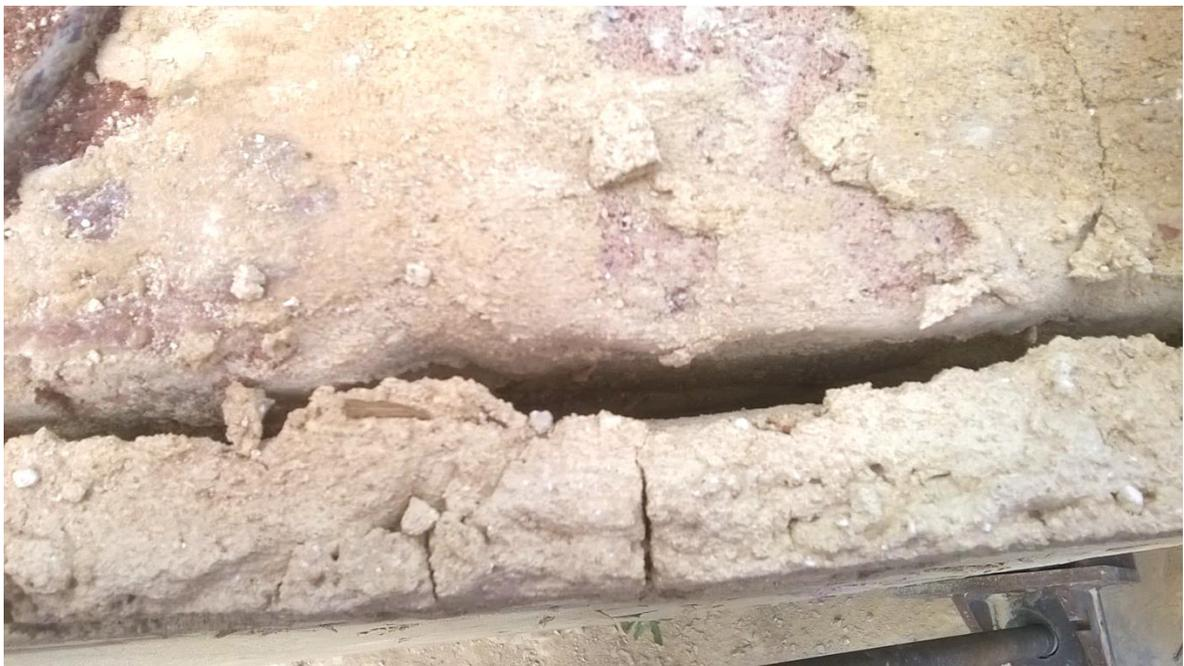
**Fotografía 5-34** Desprendimiento del mortero de revoque de la mampostería
