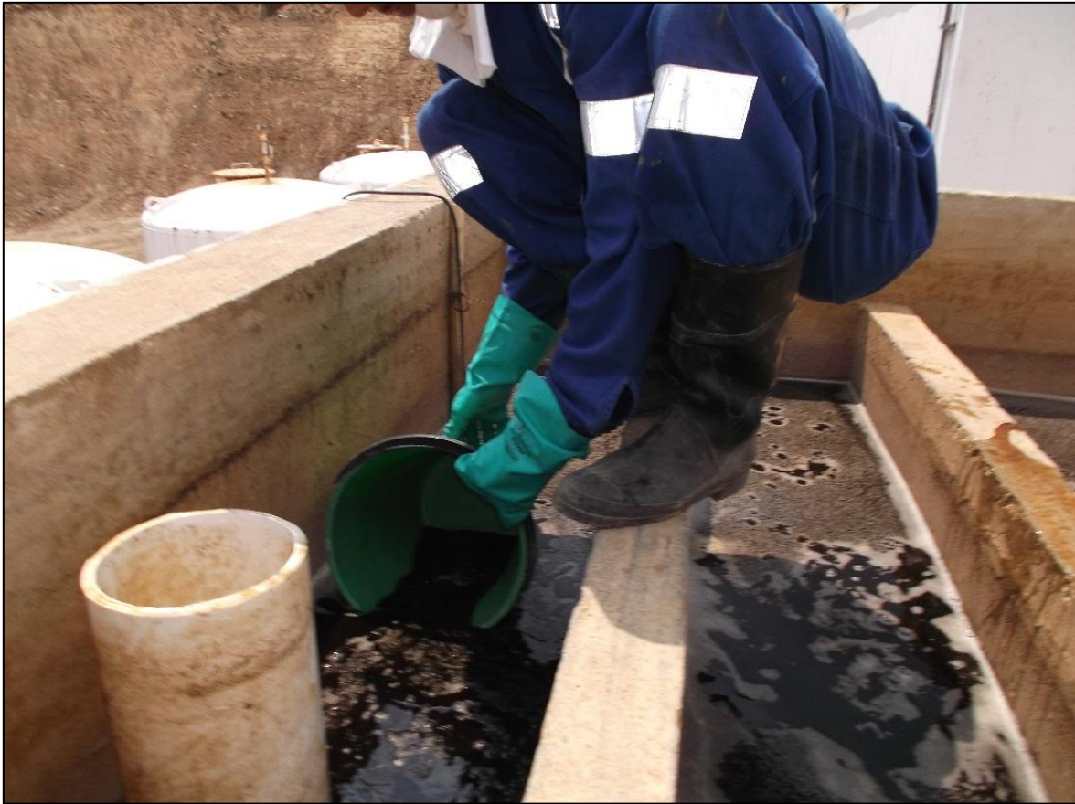
Foto 21. Monitoreo del efluente del tanque de contacto con cloro
