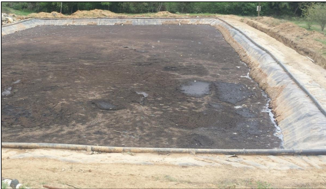
Foto 23. Encostramiento en el fondo de la laguna anaerobia
