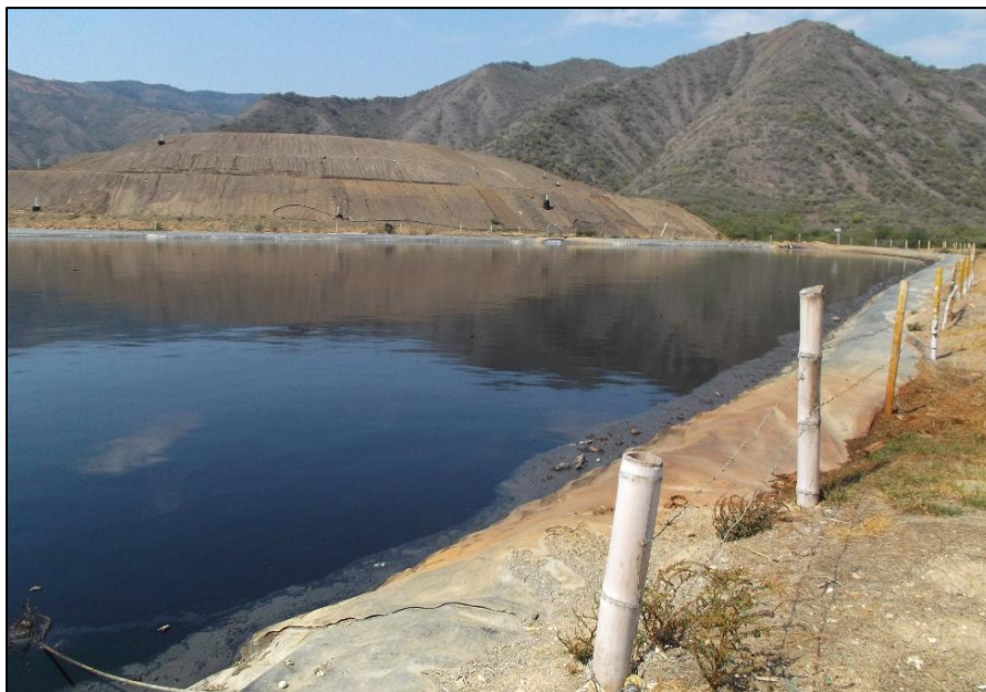
Foto 22. Laguna de homogeneización
