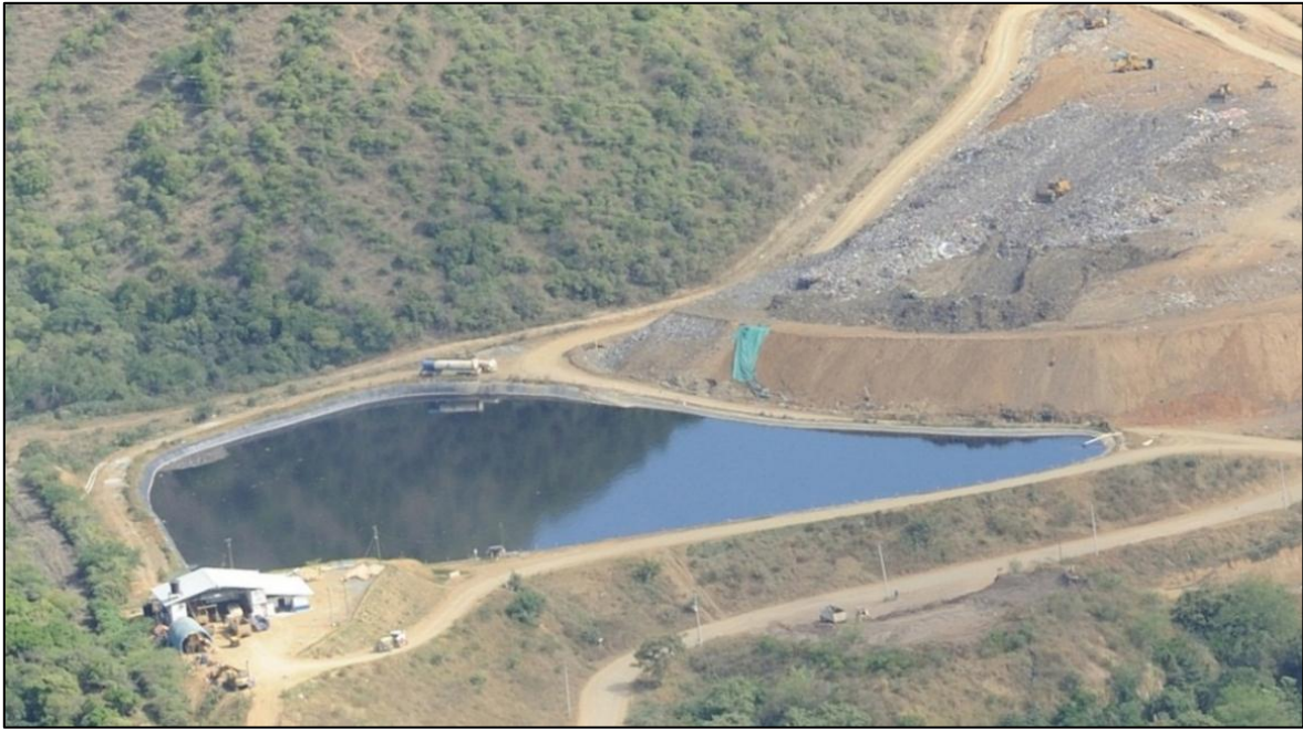
Foto 13. Laguna de homogeneización
