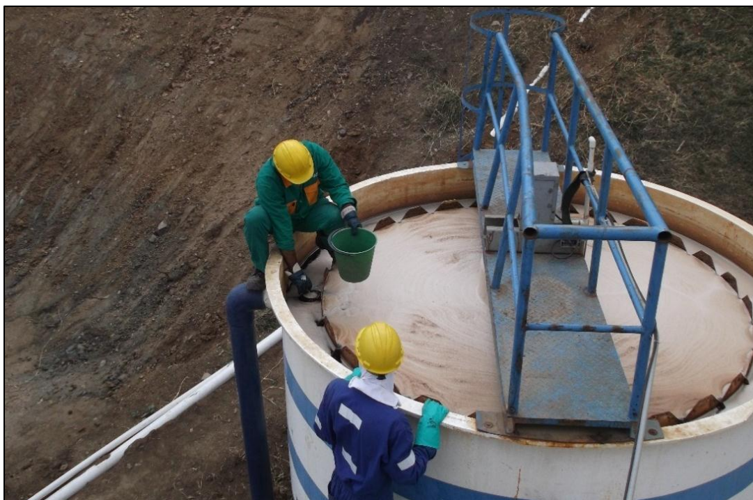
Foto 20. Monitoreo del efluente de la unidad compacta de clarificación
