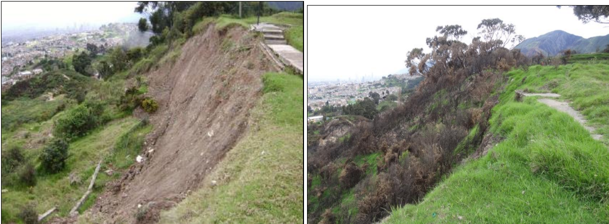
Figura 18. Comparación del estado del escarpe principal del deslizamiento en el año 2009 (izquierda) y en el año 2016 (derecha). Fuente propia.
