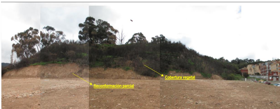
Figura 17. Panorámica actual del talud (Abril 2016). Fuente propia.
