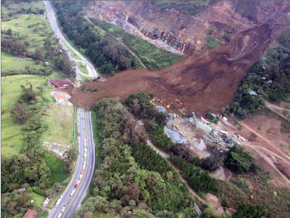
Figura 11. Deslizamiento de tierra en la vía Medellín – Bogotá, sector de Copacabana, vereda El Cabuyal, km 12+100. Octubre de 2016. Fuente: Revista Semana, (s/f)
