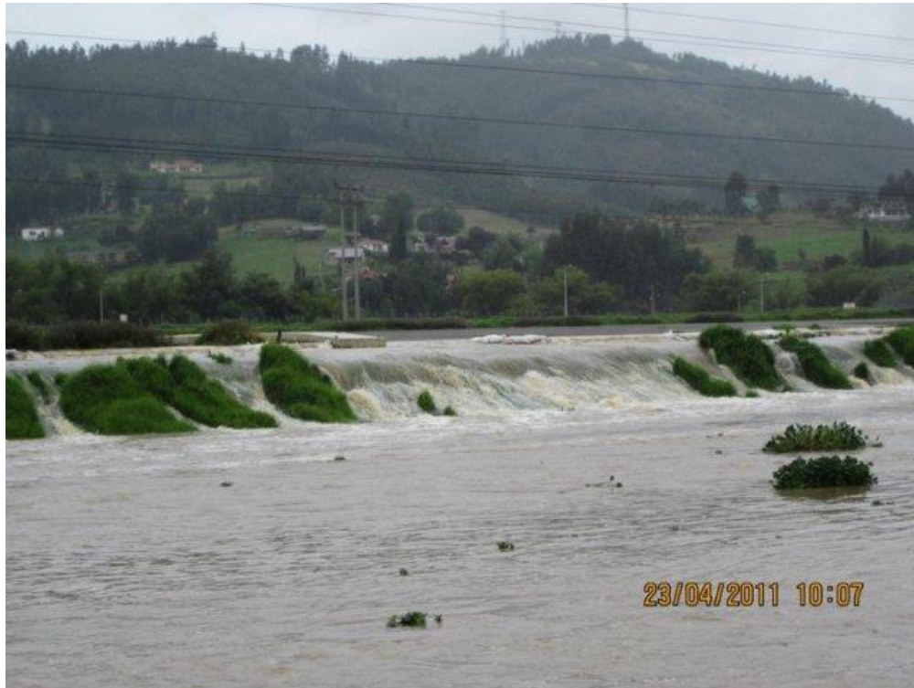
Figura 2-1 Inundaciones en las piscinas de enfriamiento de Termopaipa - Gensa
