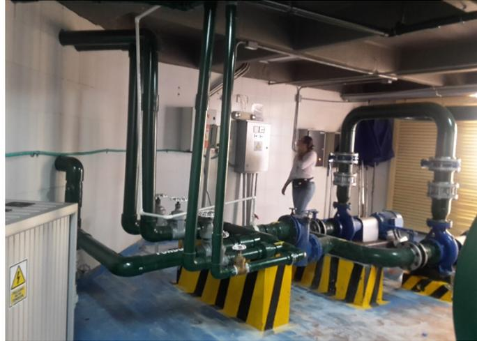
Fotografía 12 Piscina El Mirador, tuberías de succión, desnatadores y motor día y noche. Autora
