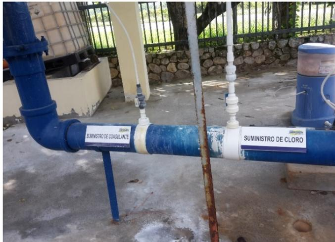
Fotografía 3 Planta potabilizadora, tuberías de suministro de coagulante y cloro. Autora
