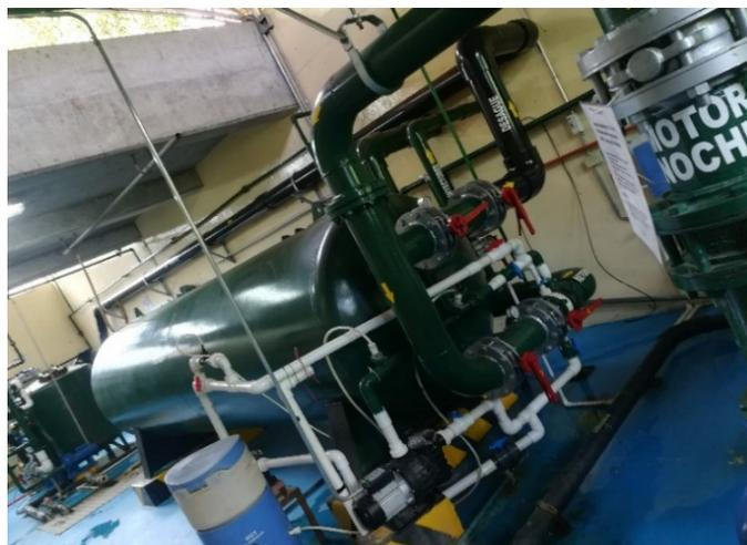
Fotografía 7 Piscina Oasis, tuberías de entrada al filtro, retorno y desagüe, y válvulas. Autora
