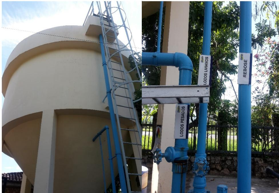
Fotografía 1 Planta potabilizadora, tanque clarificador. Autora
