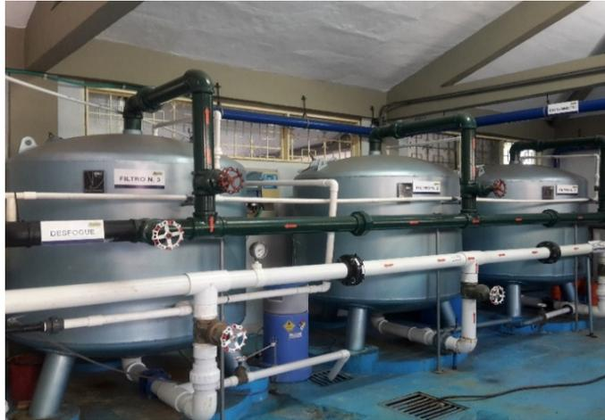
Fotografía 2 Planta potabilizadora, sistema de filtración de alta tasa. Autora
