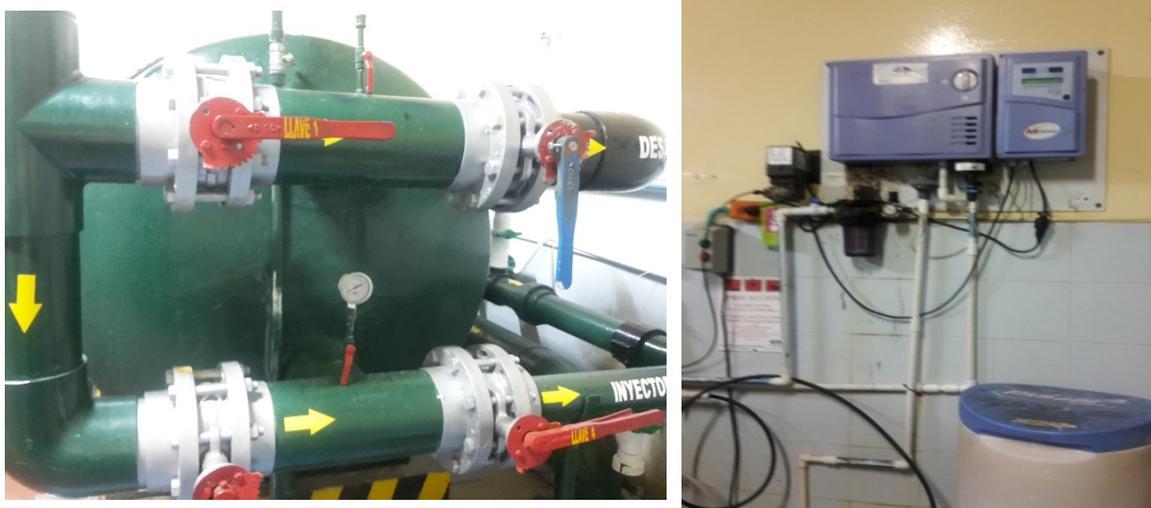
Fotografía 30 Piscina La Cascada, filtro de arena horizontal y equipo de cloración, Autora.
