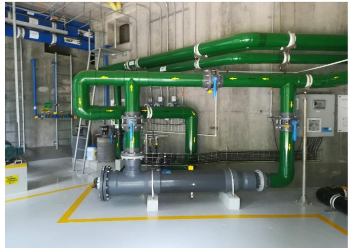
Fotografía 33 Tobogán Onda Extrema, filtro de arena horizontal y equipo de desinfección – Rayos UV, Autora.
