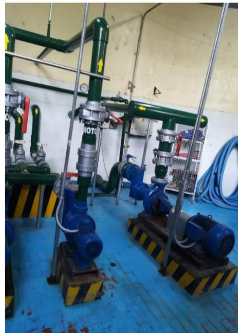
Fotografía 16 Piscina El Manantial, tuberías de succión, desnatadores y motor día y noche y motor cascada. Autora
