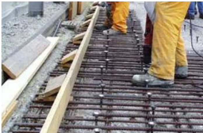
Fotografía 1-7: Anclajes en proyectos de infraestructura. Fuente: Rebarring-2012-Hilti-EC2_130
