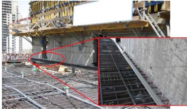
Fotografía 1-2: Anclajes en proyectos de construcción nueva. Fuente: Rebarring-2012-Hilti-EC2_130
