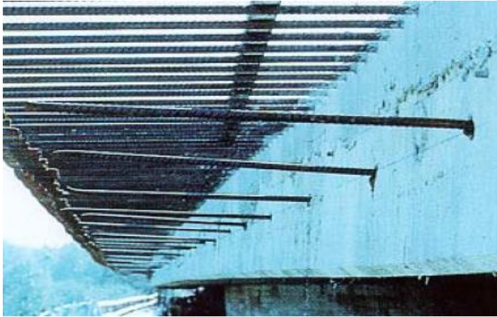
Fotografía 1-6: Anclajes en proyectos de infraestructura. Fuente: Rebarring-2012-Hilti-EC2_130
