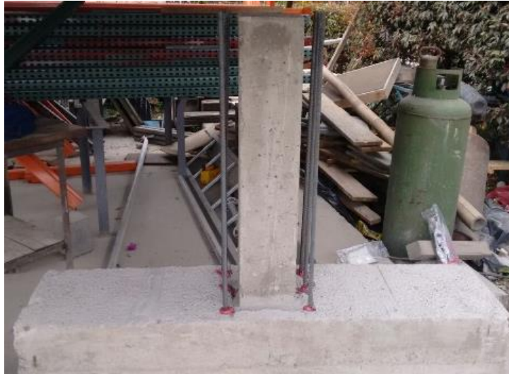
Fotografía 4-10: Varillas de refuerzo ancladas a la unión viga columna mediante adhesivo.
