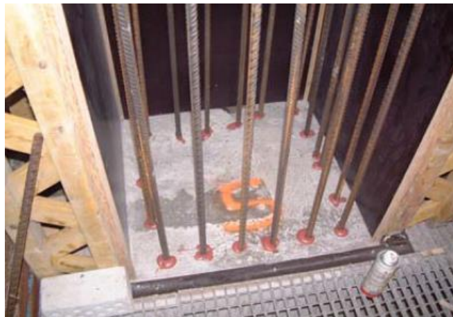
Fotografía 1-3: Anclajes en proyectos de construcción nueva. Fuente: Rebarring-2012-Hilti-EC2_130
