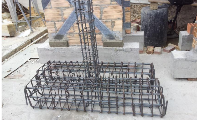
Fotografía 4-1: Refuerzo especímenes reforzados primera etapa.
