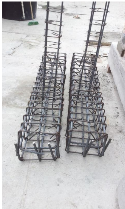
Fotografía 4-2: Refuerzo de la columna y la viga.
