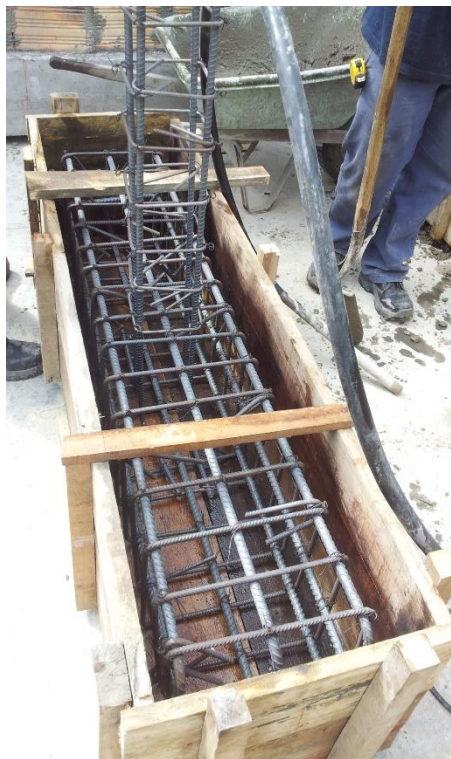
Fotografía 4-4: Refuerzo de unión viga-columna en formaleta de madera.
