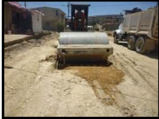
Ilustración 10 Vibrocompactador
