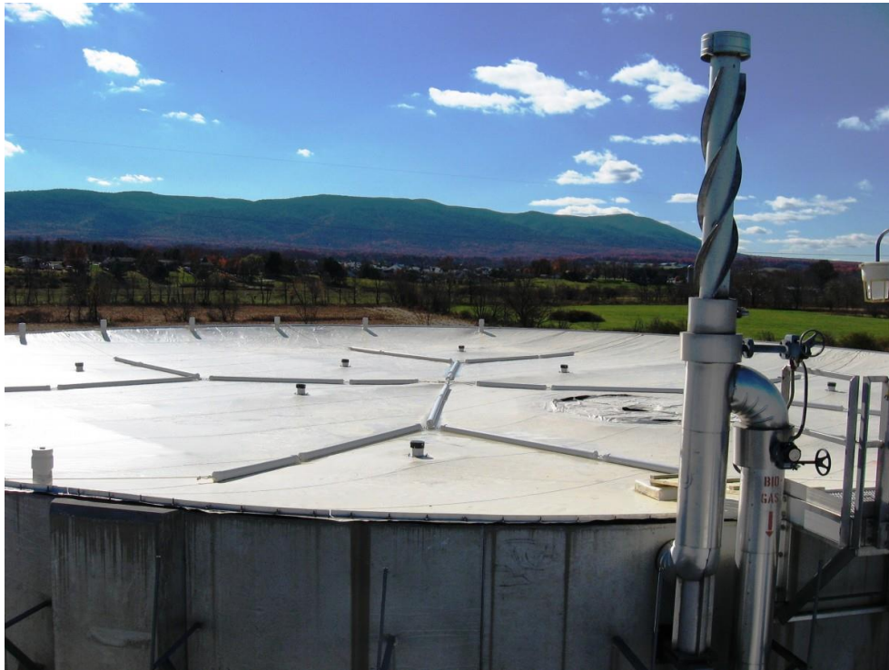
Ilustración 17 Cubierta flotante rígida.
